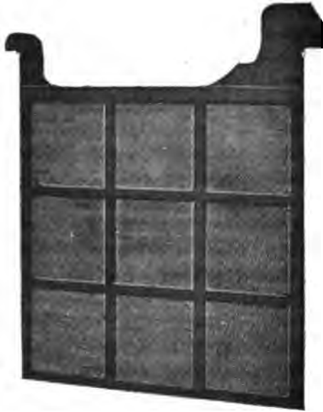
FIG. 436. — Positive à grande surface de la National Battery Co.
