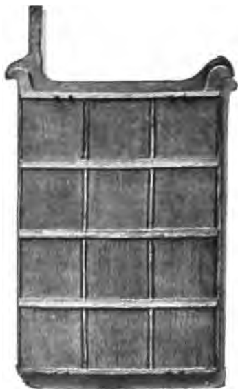
FIG. 394. — Plaque Gülcher à grande surface.
